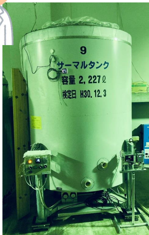
仕込み用の大型タンク
